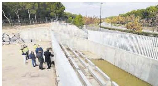
La desembocadura del nuevo canal perimetral en la Z-30.
