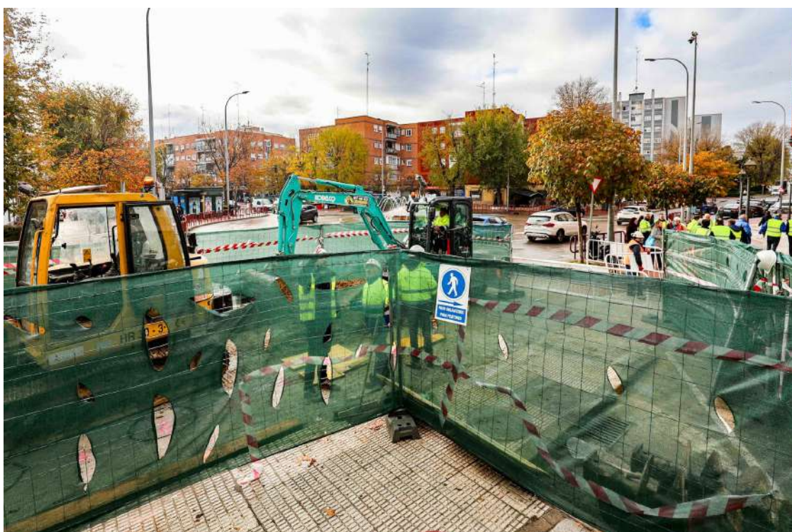
El Ayuntamiento de Móstoles renueva la red de saneamiento con una inversión de más de 12 millones de euros (Foto: Consistorio)
