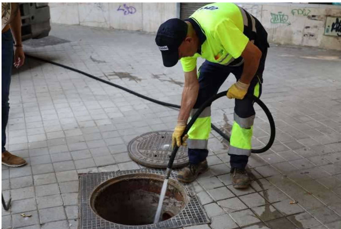
Móstoles refuerza la limpieza y mantenimiento de las rejillas del alcantarillado ante una posible DANA (Foto: Ayuntamiento)
